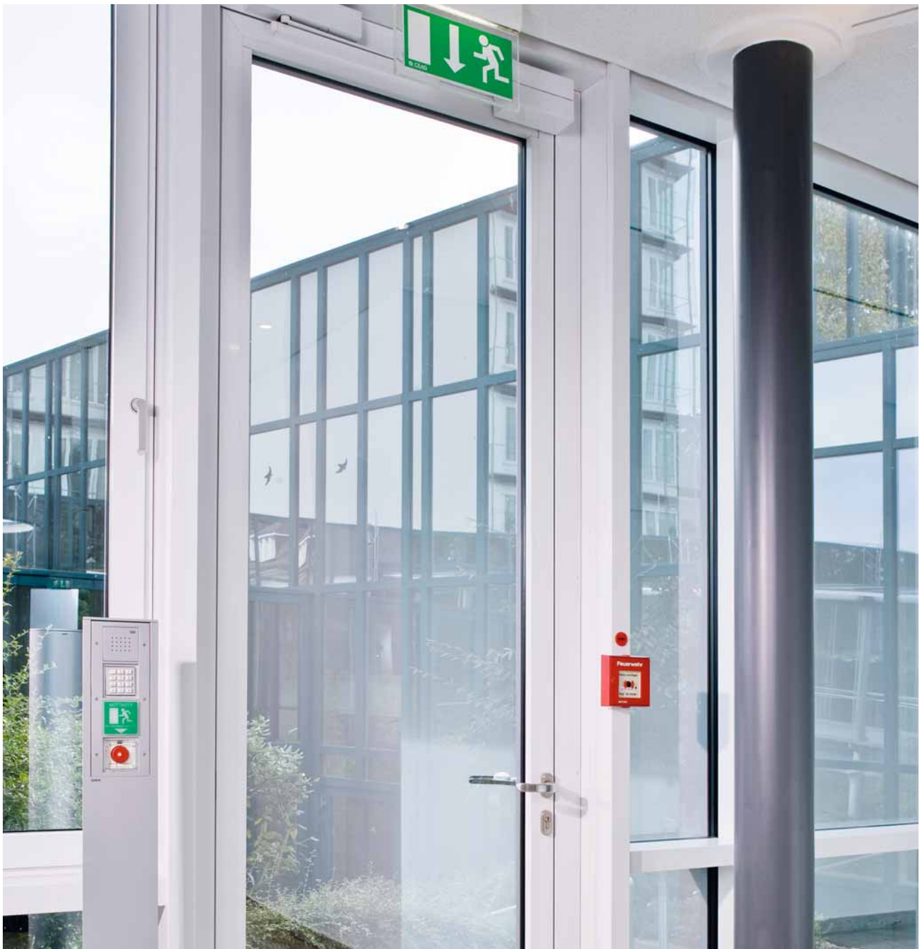
DORMA Türmanagementsystem TMS Universal mit Panik-Motorschloss SVP 2000
